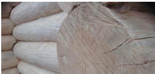
шлифовка торцов и бревен сруба
